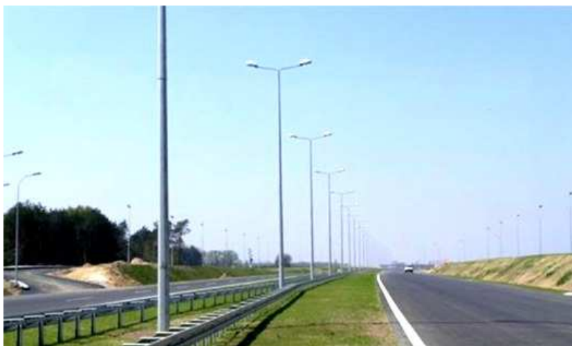
Fot. 1. Oświetlenie drogi. Słupy oświetleniowe ustawione w pasie dzielącym oraz na skarpach wykopu.
