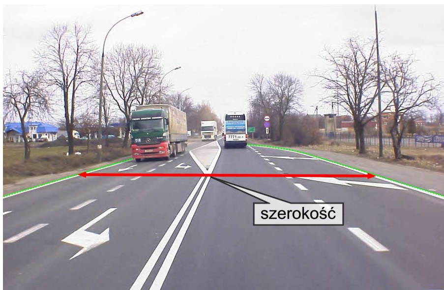
Fot. 17 Jezdnia – z dodatkowymi pasami (pasy włączenia i wyłączenia).
