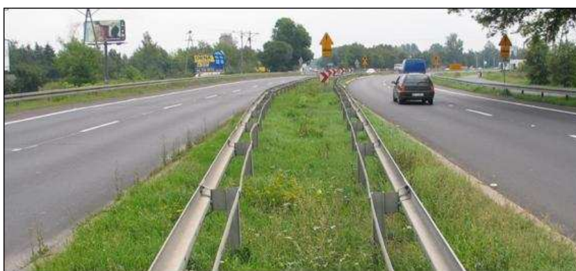
Fot. 5. Środkowe jednostronne bariery drogowe – stalowe.
