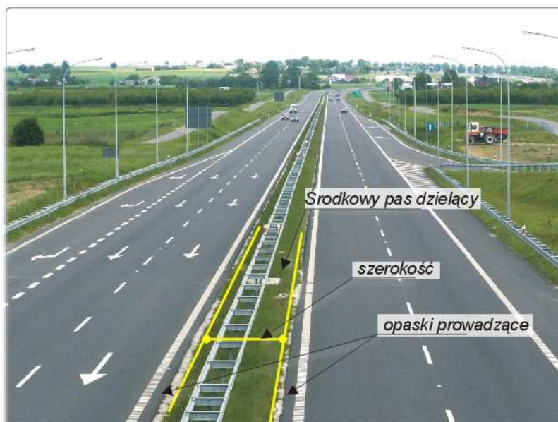
Fot. 1. Środkowy pas dzielący w przekroju szlakuwym. Szerokość środkowego pasa dzielącego, gdy występuje przy nim opaska przyjmuje się bez krawężników.
