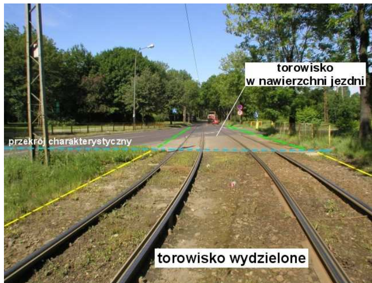
Fot. 5. Zmiana rodzaju torowiska w przekroju poprzecznym drogi.
