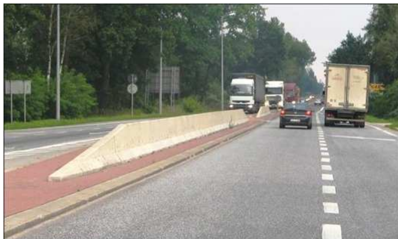
Fot. 2. Środkowa bariera drogowa – betonowa pełna.
