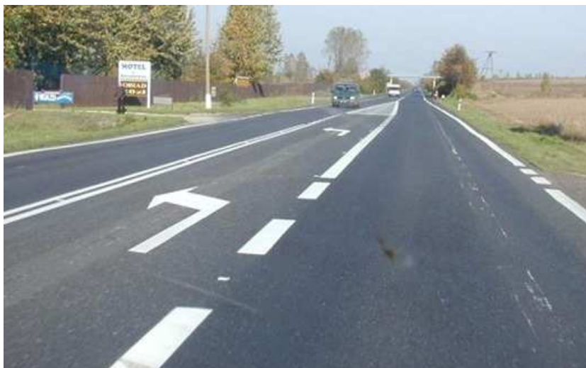
Fot. 3. Oznakowanie poziome. Linia podwójna ciągła, linie krawędziowe ciągłe, linia pojedyncza przerywana- wydzielająca, strzałki kierunkowe w lewo, powierzchnia wyłączona z ruchu.
