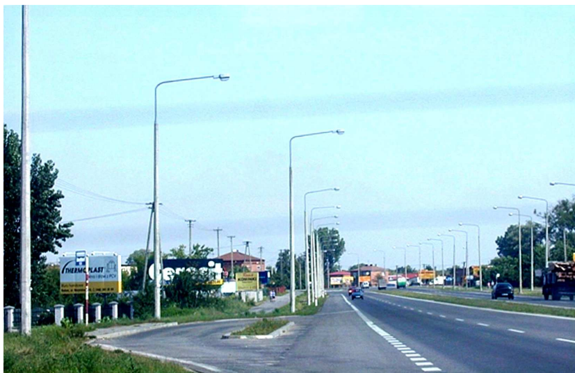
Fot. 2. Oświetlenie drogi. Słupy oświetleniowe ustawione przy zatoce autobusowej oraz w bocznych pasach dzielących.
