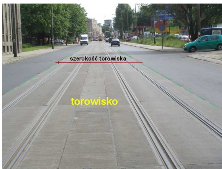
Fot. 4. Torowisko w nawierzchni jezdni zlokalizowane w osi ewidencjonowanej jezdni.
