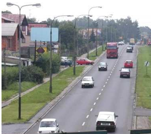
Fot. 4. Oświetlenie drogi. Słupy oświetleniowe ustawione w bocznym pasie dzielącym.
